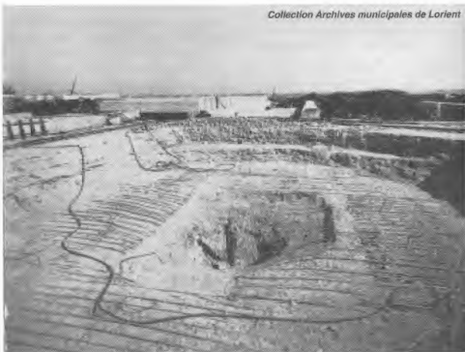
Base de sous-marins. Cratère creusé par une bombe expérimentale alliée de 6 tonnes sur le toit du bloc K3 (6 tonnes était la charge maximale que pouvait emporter un avion). Durant la seconde Guerre Mondiale, les allemands voient rapidement l'intérêt qu'ils peuvent tirer de la rade de Lorient et des infrastructures portuaires et industrielles existantes pour mener à bien la bataille de l'Atlantique. Ils y construisent entre 1941 et 1943 la plus grande base de sous-marins : 900 000 tonnes de béton pour 3 blocs ! Les deux premiers de 130 m de côté pour 18,50 m de haut, le troisième de 170 m sur 122 et 20 m de haut. Un quatrième bloc, à peine commencé, devait être construit au niveau du bassin long du port de pêche mais les événements les empêchèrent de mener à bien leur projet final.
